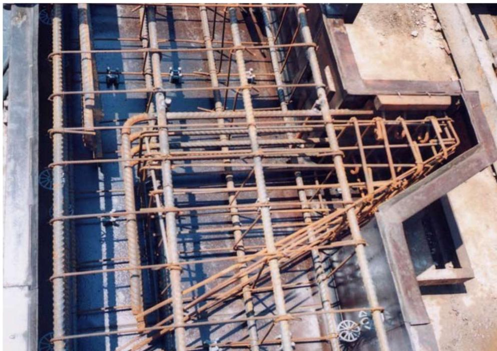
**Figura 2 – Arranjo estrutural de um consolo em pilar**
