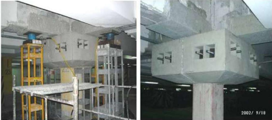
**Figura 37 - Consolo pré-moldado com barras de pós tensão**
