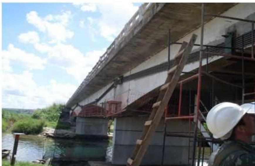
**Figura 3 – Reforço de ponte com protensão externa**
