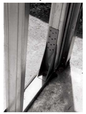
Figura 2.9 – Detalhe da ancoragem entre a estrutura e a fundação
