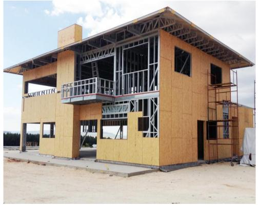
Figura 2.7 - Edificação com fechamento externo em placas de OSB
