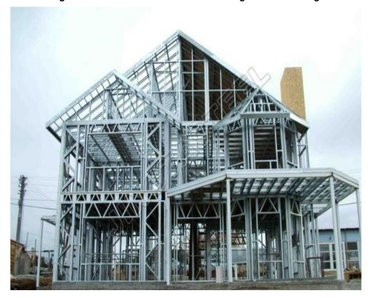
Figura 2.1 – Estrutura de residência em Light Steel Framing
