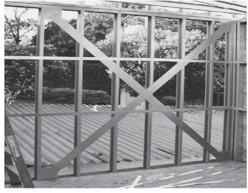
Figura 2.6 - Painel com contraventamento em "X"
