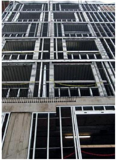
Figura 3.36 - Edifício de múltiplos pavimentos em LSF
