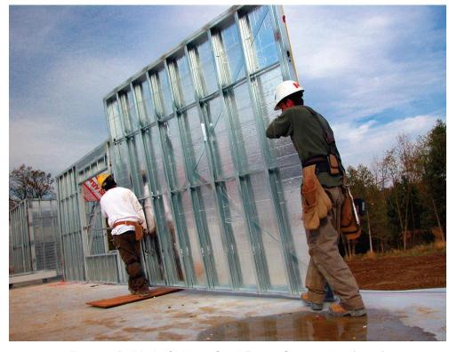
Figura 2.2 - Painel estrutural em Light Steel Framing
