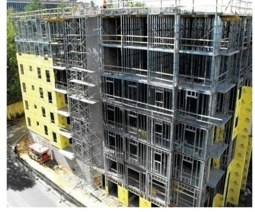
Figura 3.37 - Edifício em Light Steel Framing localizado em uma região sísmica
